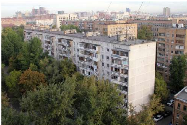
ПАНЕЛЬНЫЙ ЖИЛОЙ ДОМ СЕРИИ 1-515/9Ш
